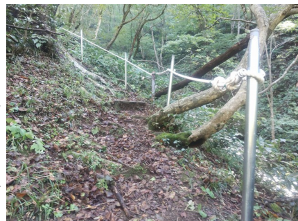
▲鋼管杭とロープの交換
