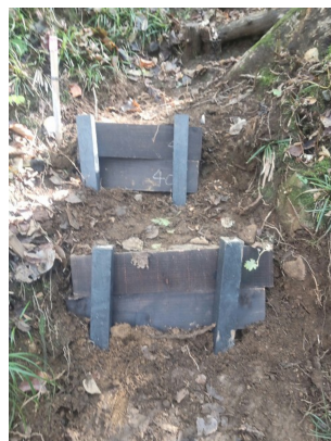
▲崩れた階段を修復
