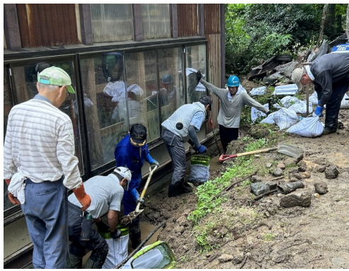
稲倉水路の側溝泥上げ作業
