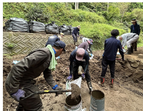
会員らの力で土砂運搬作業
